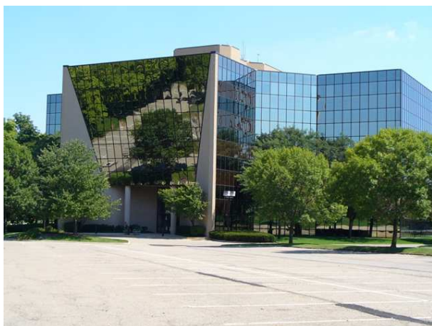
外センターⅡビル 100号室
